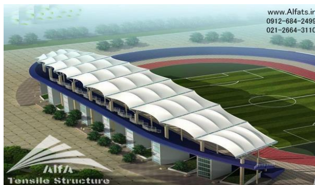
(شکل ۱۱) نمونه اجرا شده سازه های طره ای
