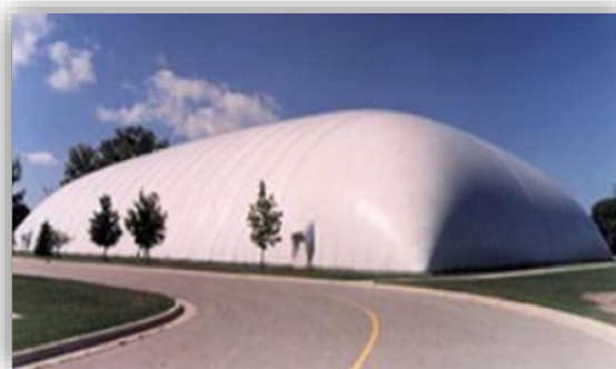
(شکل ۲) نمونه اجرا شده سازه های بادی
