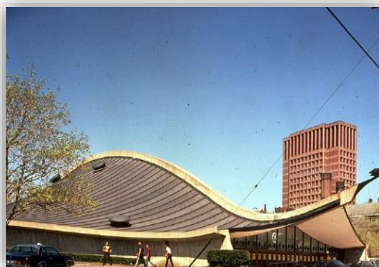
(شکل ۴) نمونه اجرا شده سازه‌های گنبد‌های کابلی
