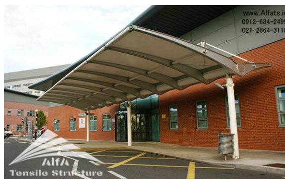
(شکل ۱۲) نمونه اجرا شده سازه های طره ای
