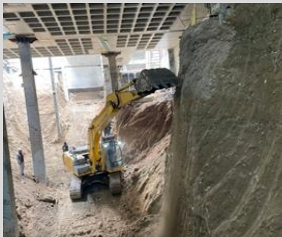
(شکل ۴-۴) اجرای خاکبرداری مرحله‌ای طبقات زیرین
