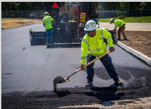
(شکل ۳-۵) اجرای روسازی آسفالتی
