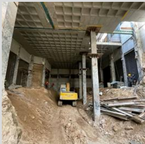
(شکل ۴-۷) مراحل اجرای گودبرداری به روش بالا و پایین
