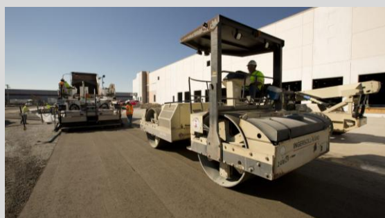
(شکل ۳-۴) اجرای روسازی بتن غلتکی
