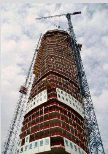
(شکل ۷-۱) اجرای نمای برج
