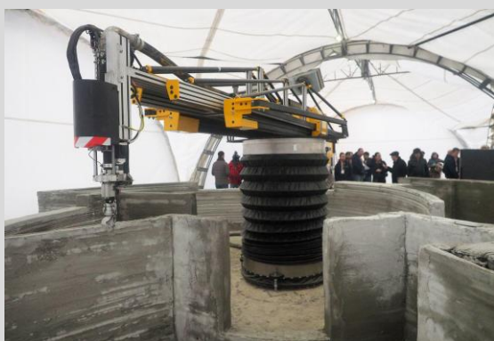
(شکل ۵-۲) ساخت با بازوهای رباتیک
