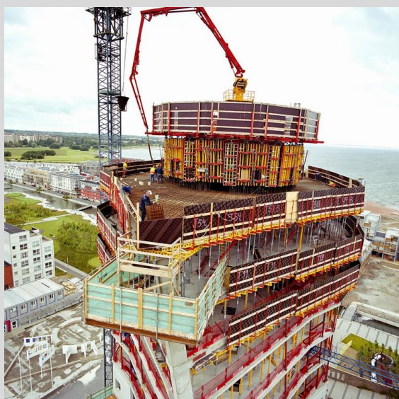
(شکل ۱-۲) بتن‌ریزی هسته و دال بتنی سازه
