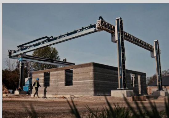
(شکل ۵-۱) ساخت با چاپگرهای دروازه‌ای
