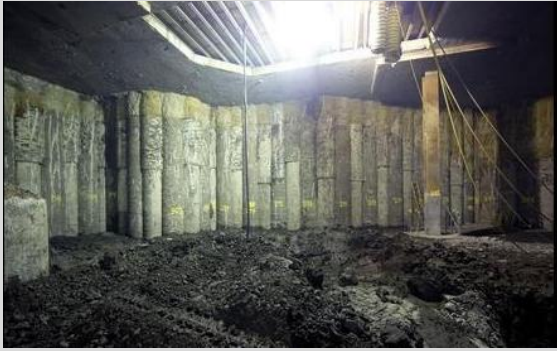
(شکل ۴-۶) اجرای دیوار دیافراگمی و شمع‌ها در برج شارد
