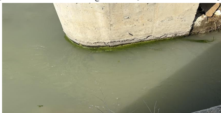
شکل ۳: محل تشکیل جریان‌های ثانویه چرخشی
