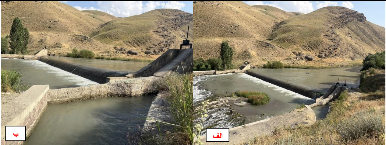
شکل ۴: نمایی از بند انحرافی کریم‌آباد ارومیه از نوع بند موازی؛ الف) نمای کلی بند و موقعیت دهانه انشعاب، ب) نمای نزدیک کانال انحراف آبگیر و دیواره مایل جدایش جریان
