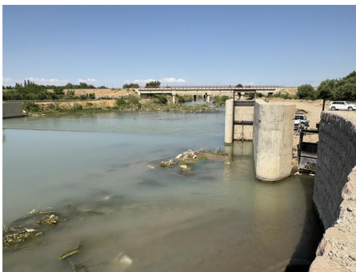
شکل ۲: نمای بالادست یک بند انحرافی زاویه‌دار و تجمع بار رسوبی در صلیب دهانه آبگیر جانبی
