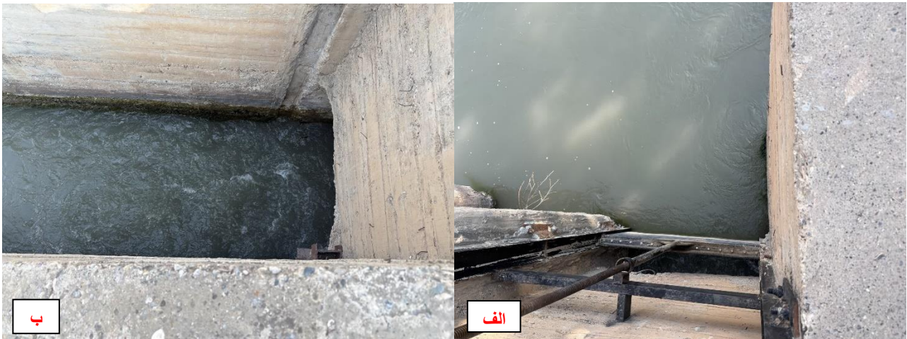
شکل ۵: المان‌های تنظیمی هیدرولیک رسوب؛ الف) شفت و مجرای کنترل دریاچه آبگیر (محل شکل‌گیری جریان ثانویه)، ب) کانال تندآب بتنی خروجی و زون گردابی محلی پایاب
