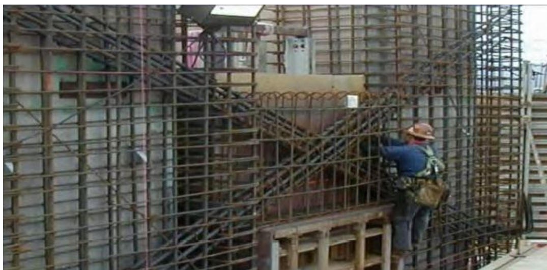
شکل ۱-۲ تیر همبند بتنی با آرماتورهای برشی قطری [۱۲]
