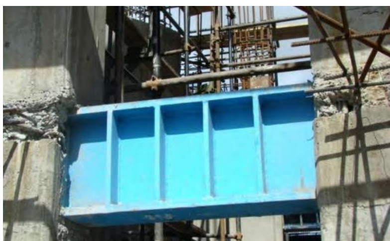
شکل ۲-۴ تیر همبند فولادی در دیوار برشی کوپله [۱۴]
