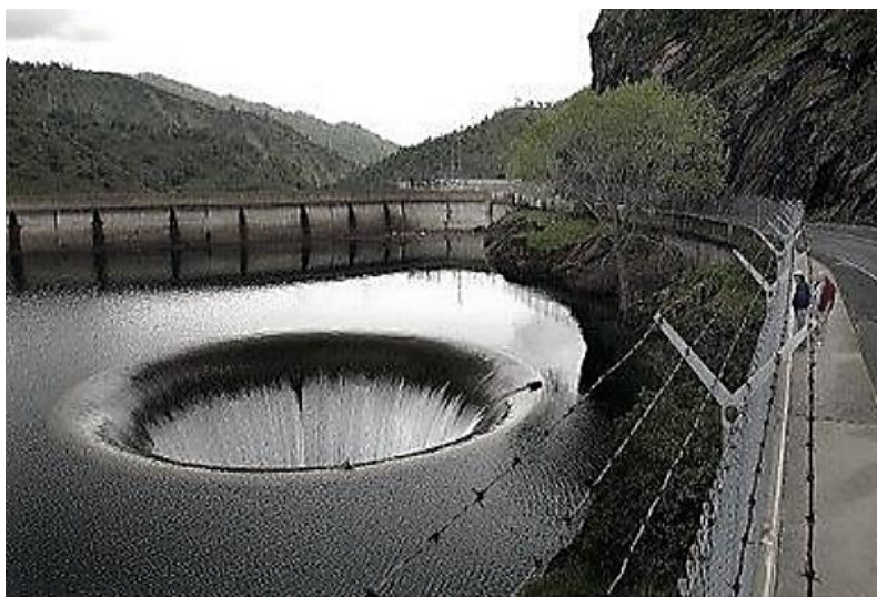
شکل ۱-۷ سرریز نیلوفری
