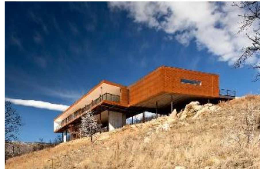
تصویر ۴۹ Sunshine Canyon Residence
