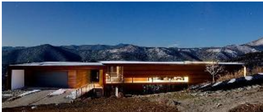
تصویر ۶۴ Sunshine Canyon Residence
