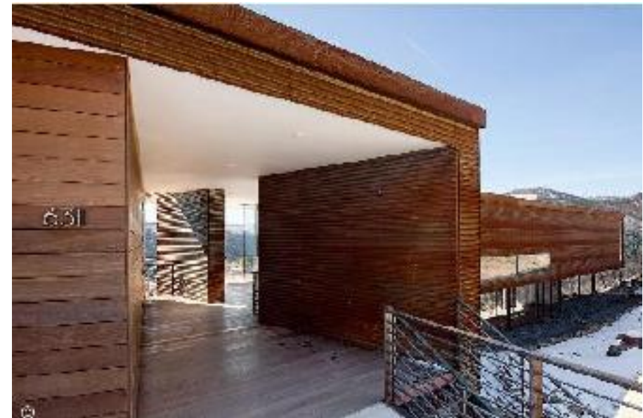
تصویر ۵۱ Sunshine Canyon Residence
