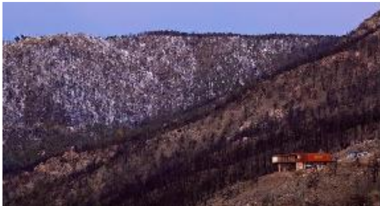
تصویر ۵۰ Sunshine Canyon Residence
