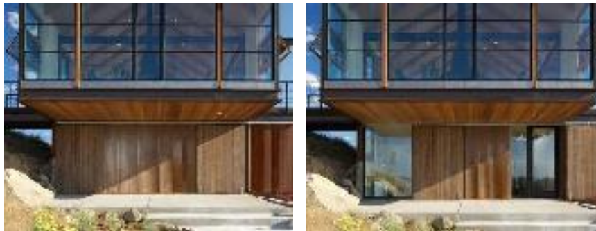
تصویر ۴۷- قابلیت باز و بسته شدن جداره ی چوبی روی در ها و پنجره ها جهت کنترل انتقال انرژی
