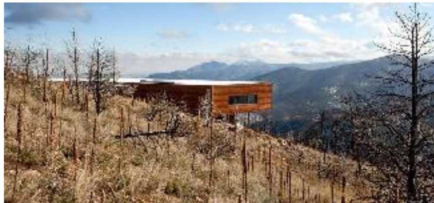
تصویر ۶۵ Sunshine Canyon Residence
